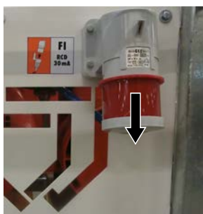
Abb. 27: Stromzufuhr unterbrechen
