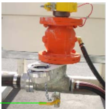
Abb. 37: Lufthahn öffnen
